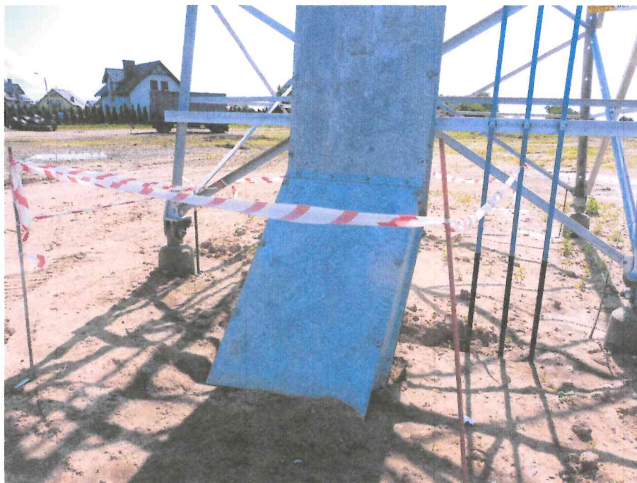
Fot. nr 5. Wyprowadzenie linii kablowej „Szamotuły” na słup.
