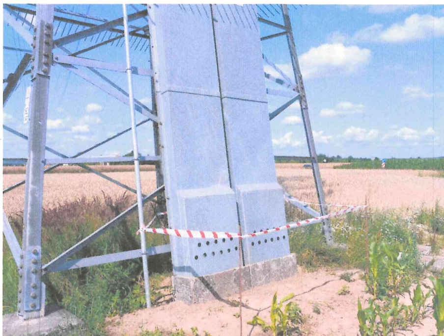
Fot. nr 6. Wyprowadzenie linii kablowych „Podlesiec” oraz „Drawski Młyn” na słup.
