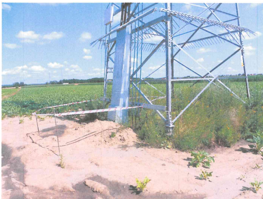
Fot. nr 7. Wyprowadzenie linii kablowych „Samolęż” na słup.
