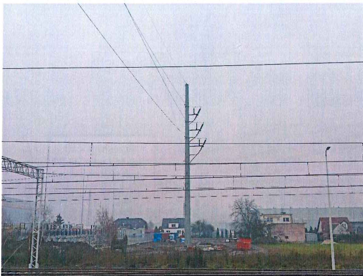
Zdjęcie nr 2. LWN 110 kV relacji Wronki – RS Samoleź, przęsło nr 9 – 10.
