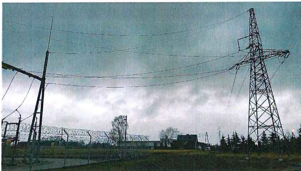
Zdjęcie nr 1. LWN 110 kV relacji RS Pamiątkowo – GPZ Szamotuly – widok fragmentu obiektu
